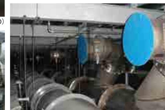
●ステンレス特有ガス排気ダクト(S.S.D-PEL)
