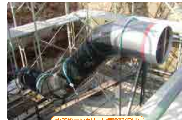
水管橋コンクリート埋設部 (PU)
