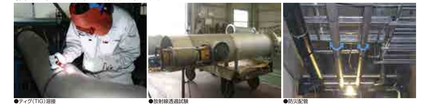
●ティグ(TIG)溶接 ●放射線透過試験 ●防火配管
