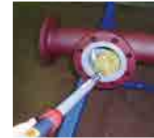
● ピンホール検査
